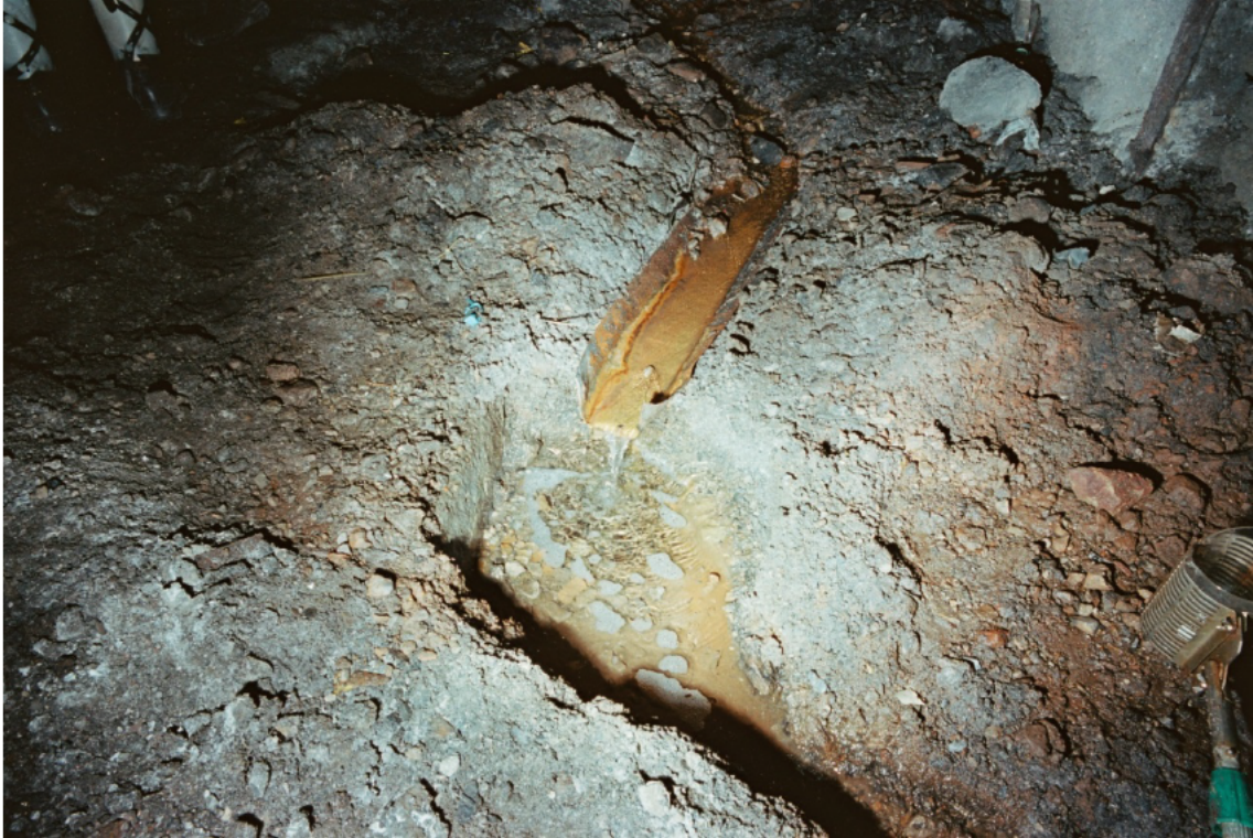
Abb. 28: Beispiel für ein offenes Gerinne mit Erosionspotential im Schacht Grimberg
