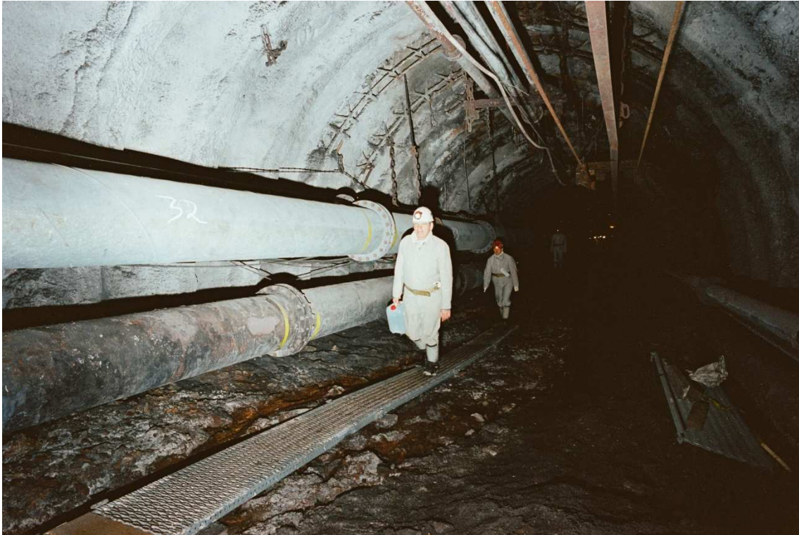
Abb. 10: Röhrensystem, Hauptwasserweg im BW Haus Aden/Monopol (Foto: RAG)
