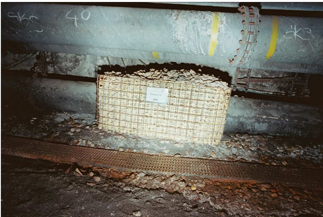
Abb. 11: Rohrleitung DN 500 mit Unterbrechungen und definierten Zutrittstellen unter der Kiesschüttung (Foto: RAG)
