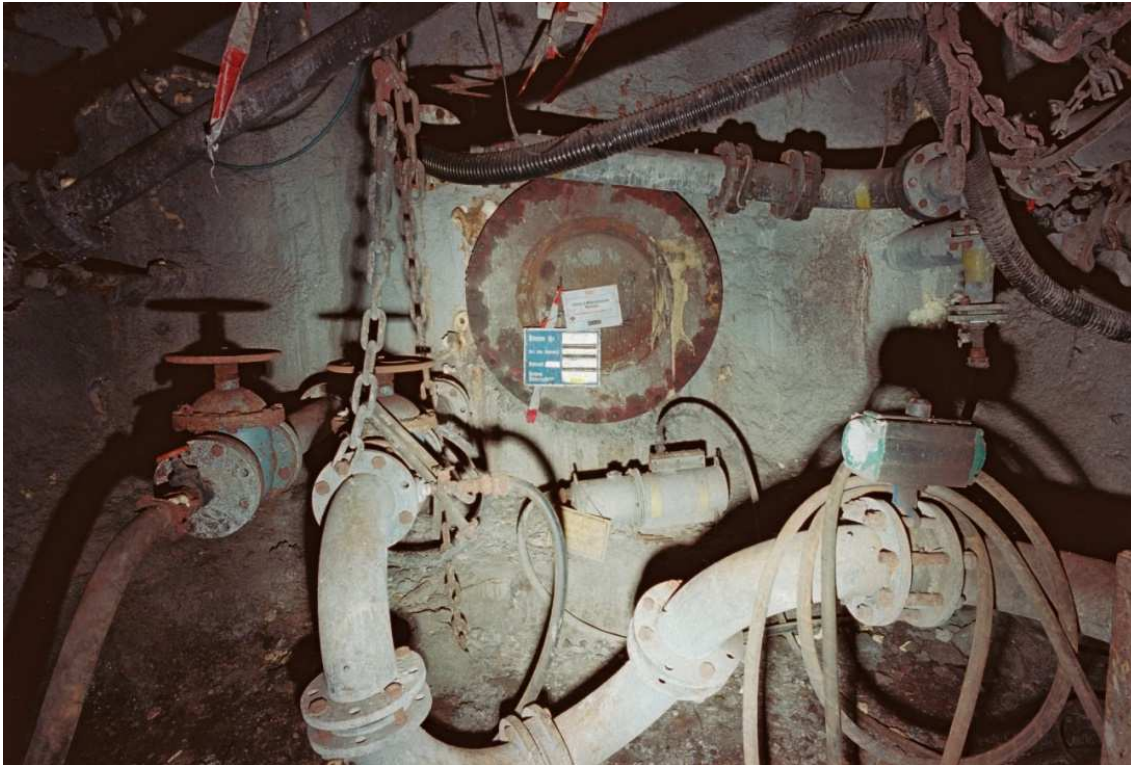
Abb. 13: Damm 2657 mit verschraubter Öffnung zur Wiederherstellung der Durchlässigkeit (Foto: RAG)
