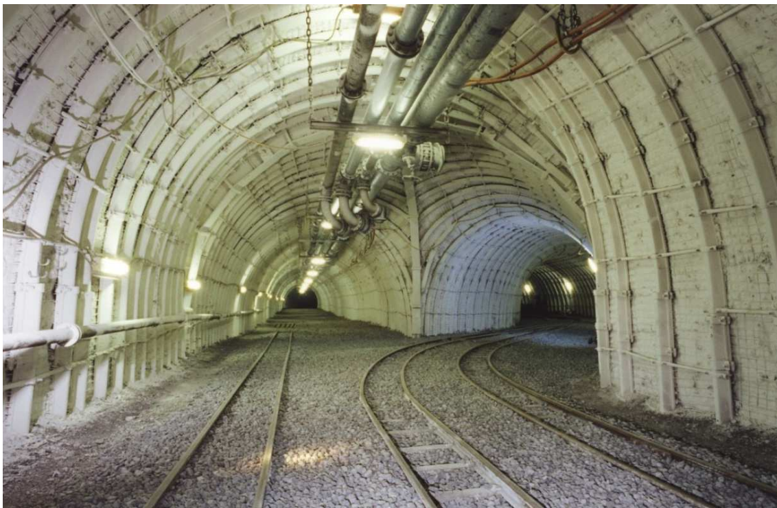
Abb. 9: Röhrensystem, geschotterter Hauptwasserweg im BW Auguste Victoria (Foto: RAG)
