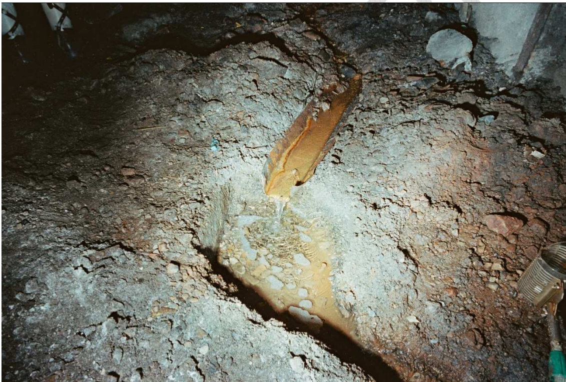
Abb. 65: Beispiel für ein offenes Gerinne mit Erosionspotential im Schacht Grimberg (Foto: RAG)
