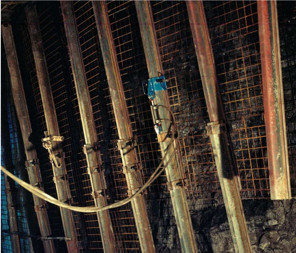
Abb. 20: Hydraulische Anbindung des Röhrensystems an das Gebirge durch einen offenen Ausbau (Foto: RAG)
