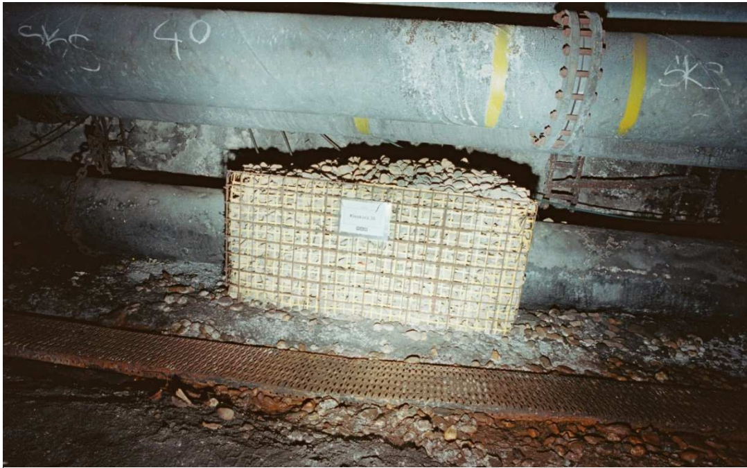
Abb. 19: Rohrleitung DN 500 mit Unterbrechungen und definierter Zutrittsstelle unter der Kiesschüttung (Foto: RAG)
